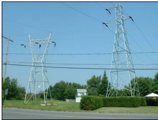
Ligne électrique traversant un milieu de vie
