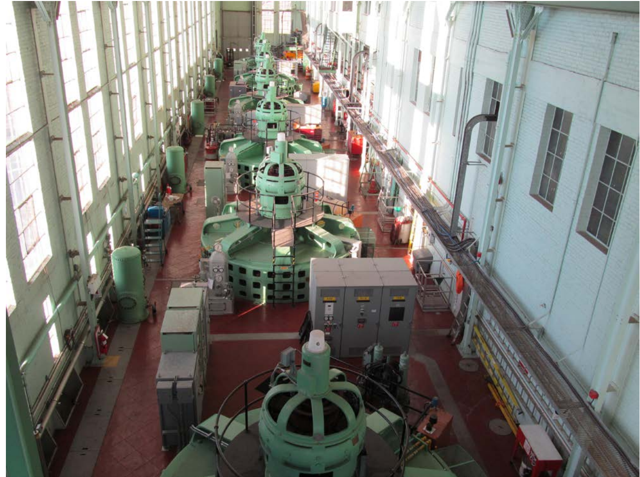
Turbines de la centrale de la Chute Hemmings
