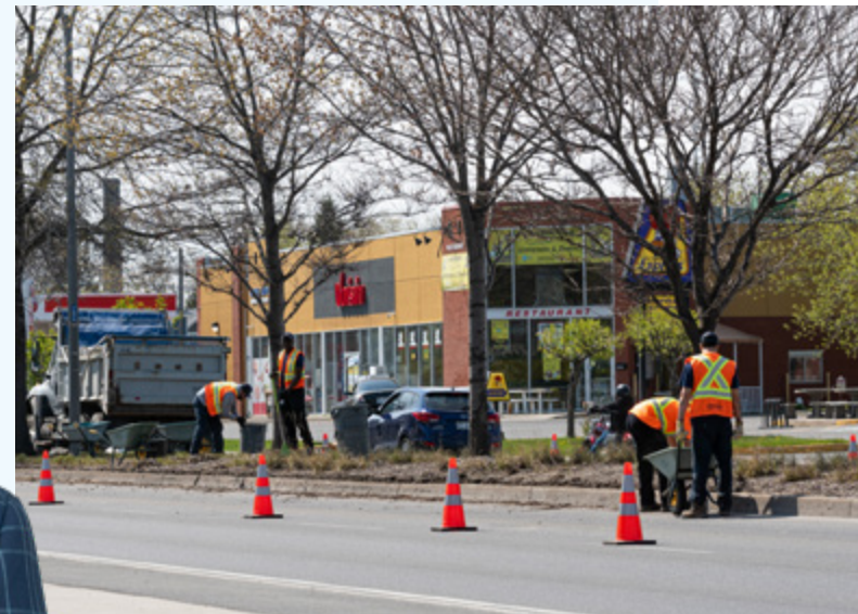
Travaux d'entretien réalisés sur le boulevard Saint-Joseph.
