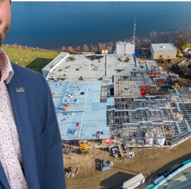
Construction de l'usine de traitement de l'eau.
