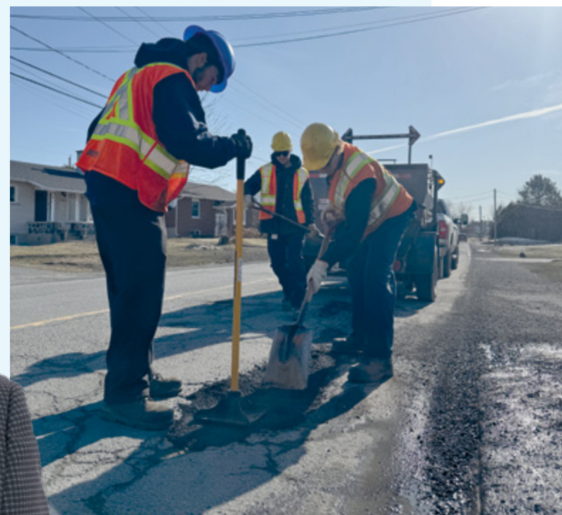
Opération colmatage de nids-de-poule dans les rues de la ville.
